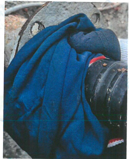
G1 反射炉废气排放口
