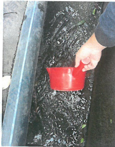
WW1 废水总排口
